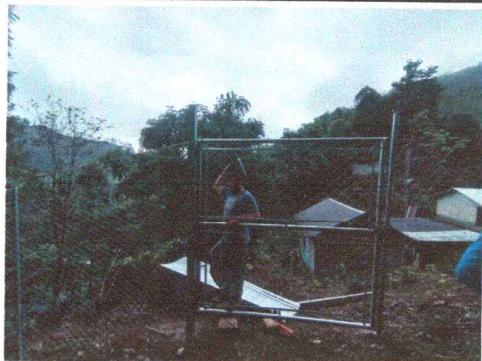
Foto1: Cambio del porton de madera, hacia un porton de metal.
