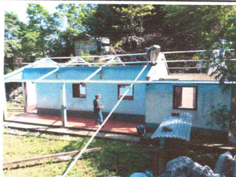
Foto 3: Proceso de instalacion de estructuras metalicas del entechado.
