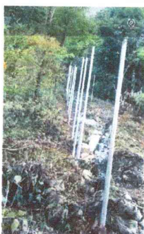
Foto 5: Colocacion de los tubos galvanizados, sustituyendo a la de madera.
